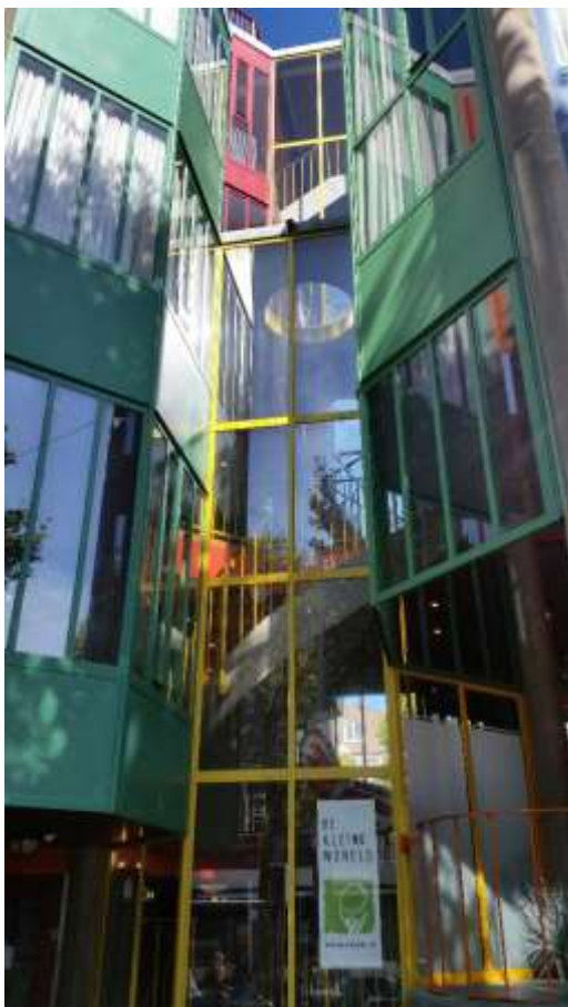
Hubertushuis detail nieuwe gevel. Fotograaf Cees Camel.
