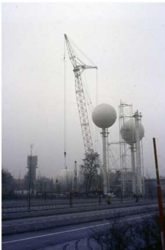
Het derde waterreservoir wordt op de nieuwe watertoren geplaatst, 1972. Links staat nog de oude watertoren. Fotograaf Thael.
