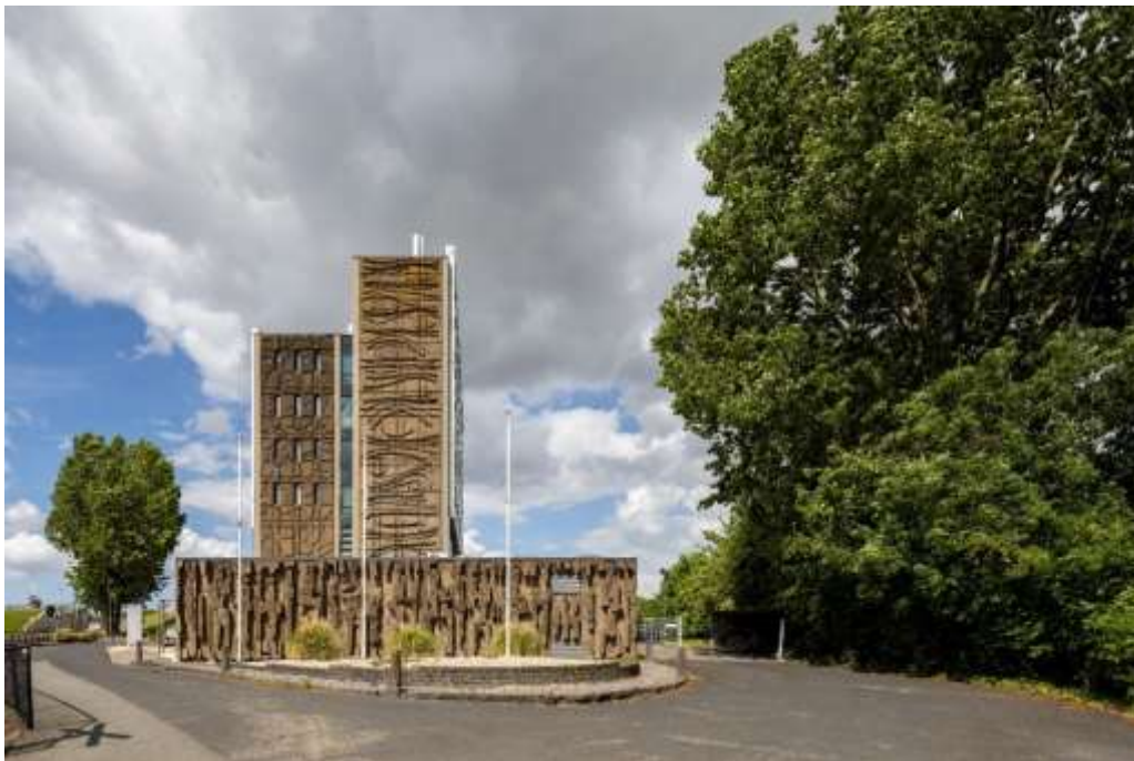
Aanzicht kopgevel zuidzijde van het Eemsmondgebouw vanaf de ingang van het terrein. Fotograaf Wouter van der Sar.
