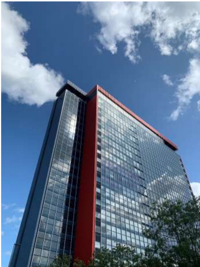
Hoogbouw voor de faculteit Elektrotechniek in Delft. Fotograaf Jacqueline von Santen.
