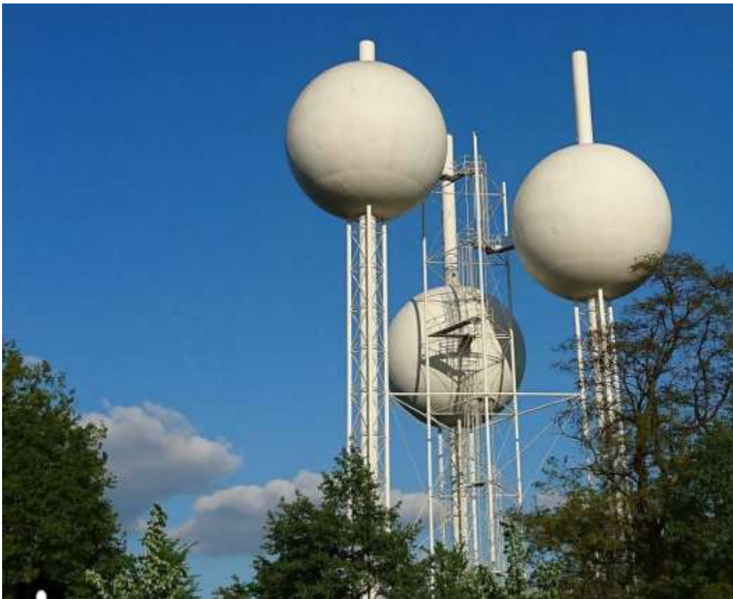
De watertoren in Eindhoven. Fotograaf Stefan Timmers.
