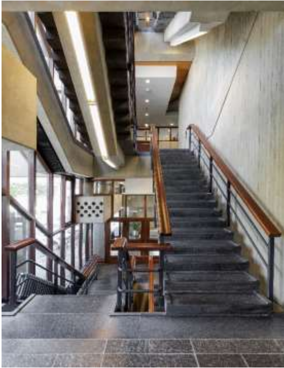
Trappenhuis van stadhuis Terneuzen. Fotograaf Chris Booms.
